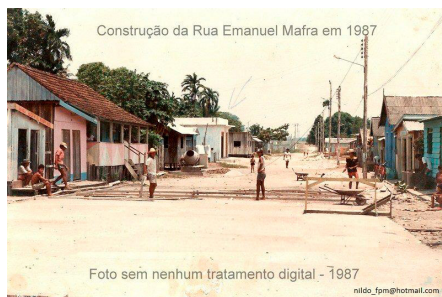
Figura 8: Construção da rua Emanuel Mafra.
